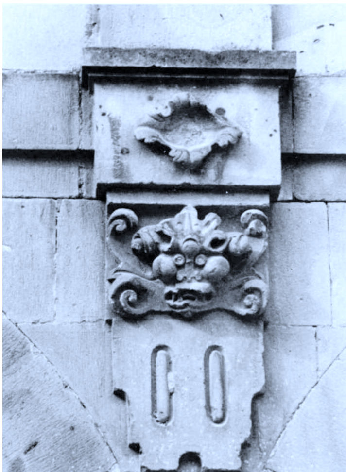
Fot. 8. Detalle decorativo del porche de la iglesia de San Martín de Ataun.
