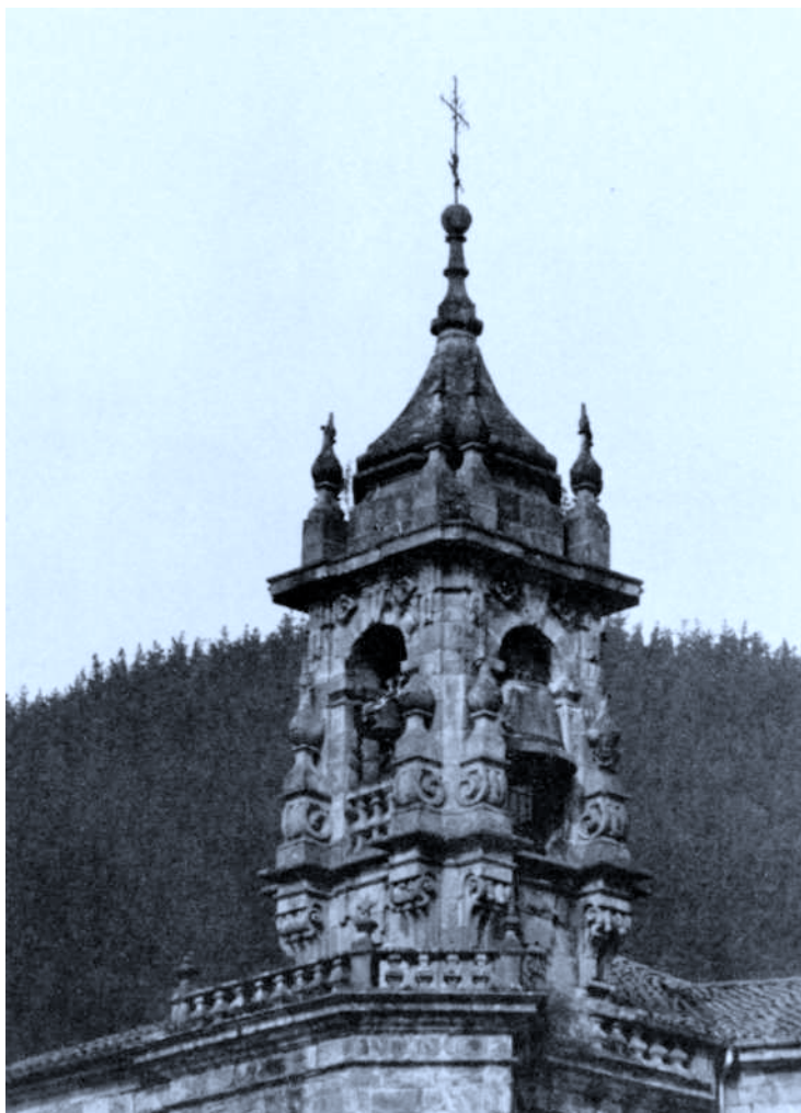
Fot. 5. Torre de la iglesia de San Martín de Ataun.
