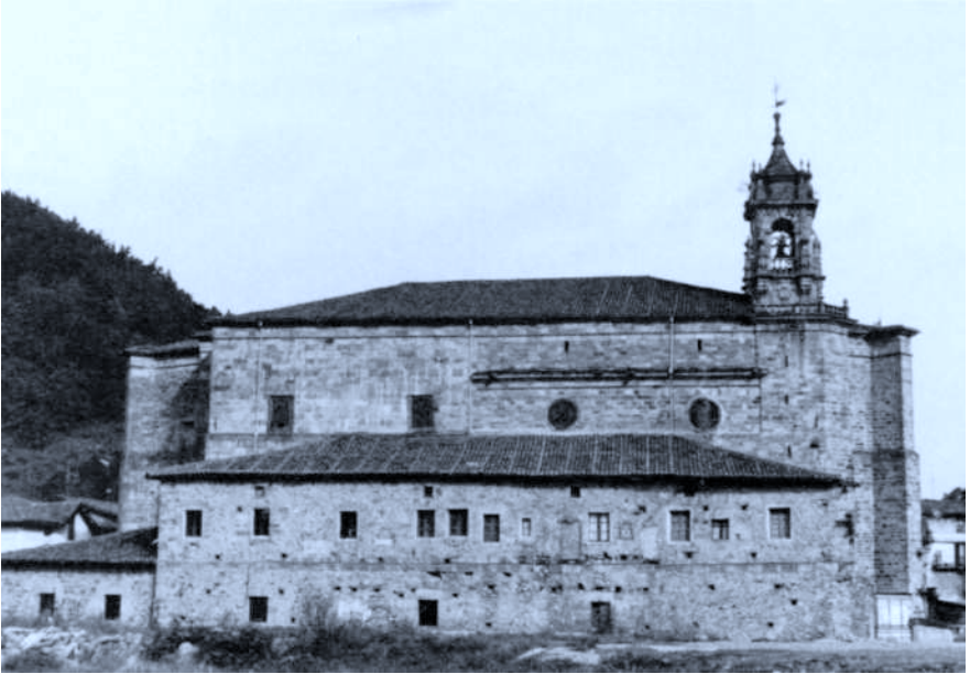
Fot. 2. Fachada sur de la iglesia de San Martín de Ataun.
