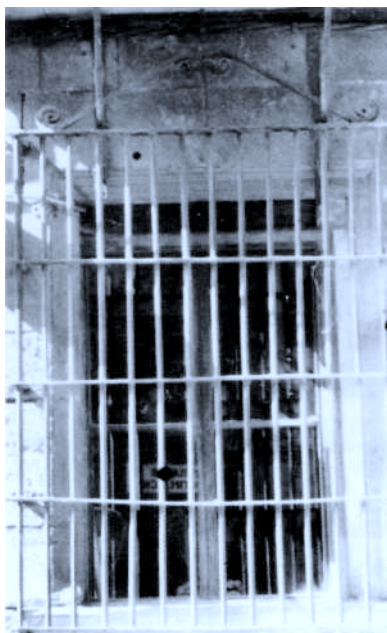
Lám. 8. 1. Verja de la antigua entrada de la parroquia de Santiago, procedente de Leyre; 2. Verja, Calle Mayor, 14, Palacio de los Guenduláin.
