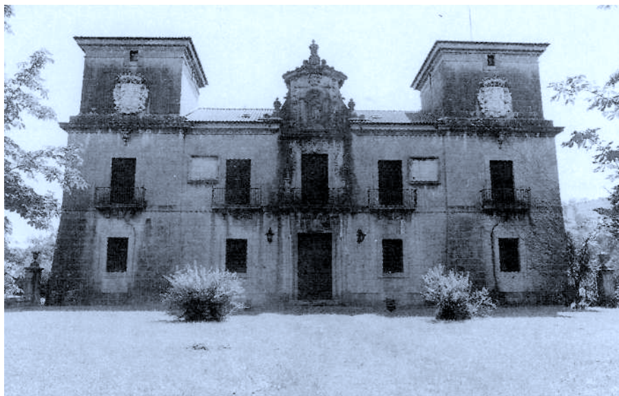
Palacio de Zubieta (Ispaster). Fachada principal
