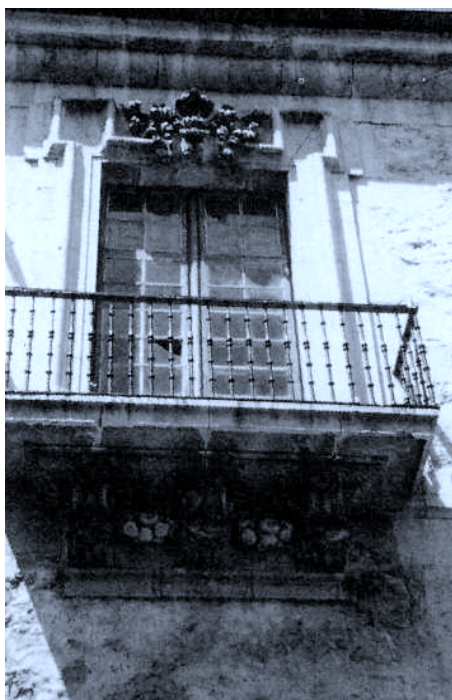
Palacio de Zubieta. Balcón de la fachada oriental
