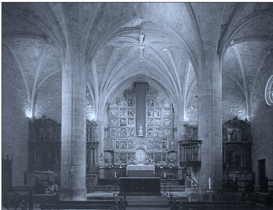
Santa María de Galdácano; enjarje de los nervios en un pilar cilíndrico. Ampliación del siglo XV conforme a un modelo de planta de salón.
