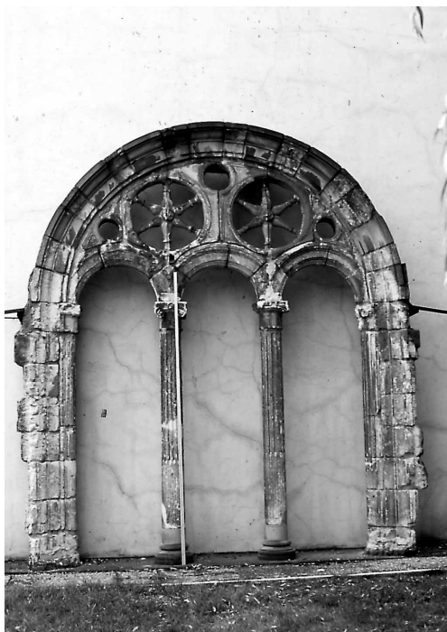
Vitoria, Hospital de Santiago: Celosía del antiguo claustro.
