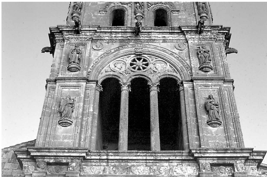
Santa María del Campo (Burgos): Celosía de la loggia en la torre.
