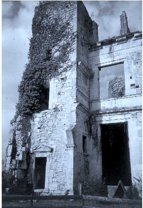
2. Bidache: Tourelle d'escalier et amorce de la galerie à arcades
