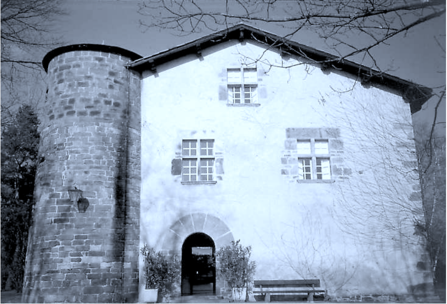
5. Ispoure: Larrea - façade Sud.
