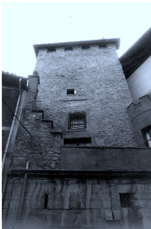
2. Torre de la Casa Consistorial de Orduña.
