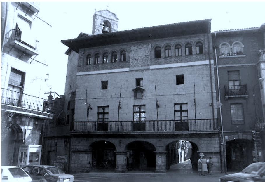
1. Casa Consistorial de Orduña.
