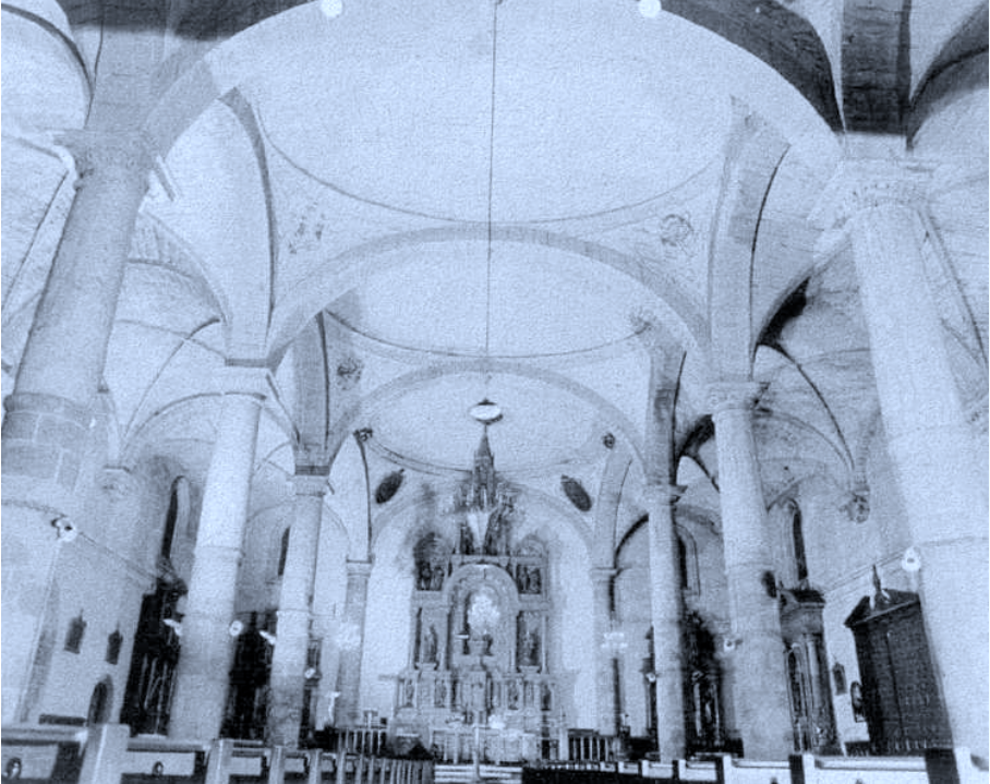
3. Interior del templo antes del inicio de las obras.
