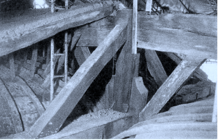
6. Otro aspecto del sistema constructivo oculto.
