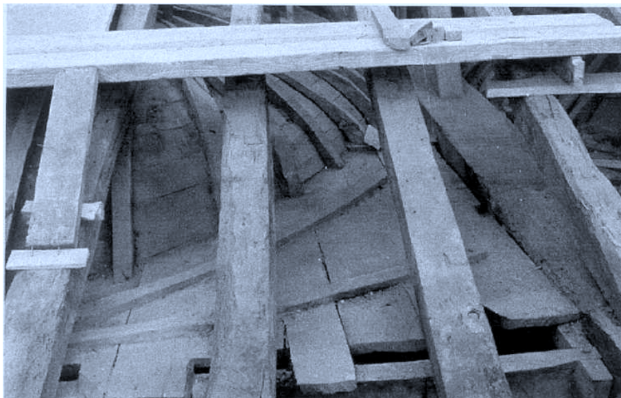
4. y 5. Distintos aspectos del sistema constructivo oculto.
