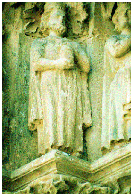
Detalle de las Dovelas.
