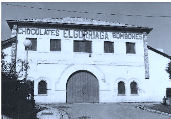
Lámina 24. Edificio construido para Garaje Citroën en Irún.
