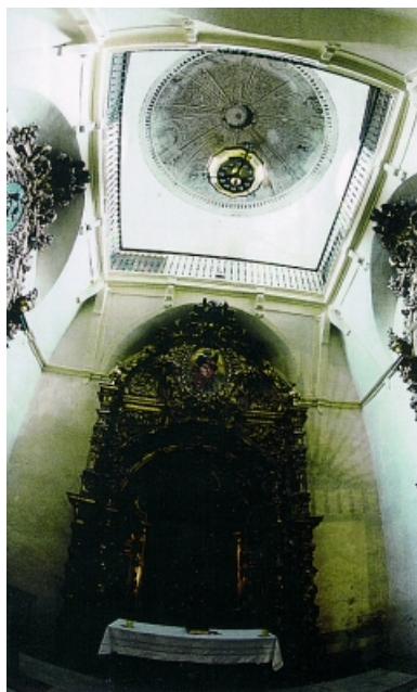
Foto nº 1: Vista interior de la capilla hacia el oeste
