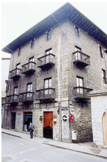
Fig. 2. Casa Moyúa Barrena. Fachada principal.
