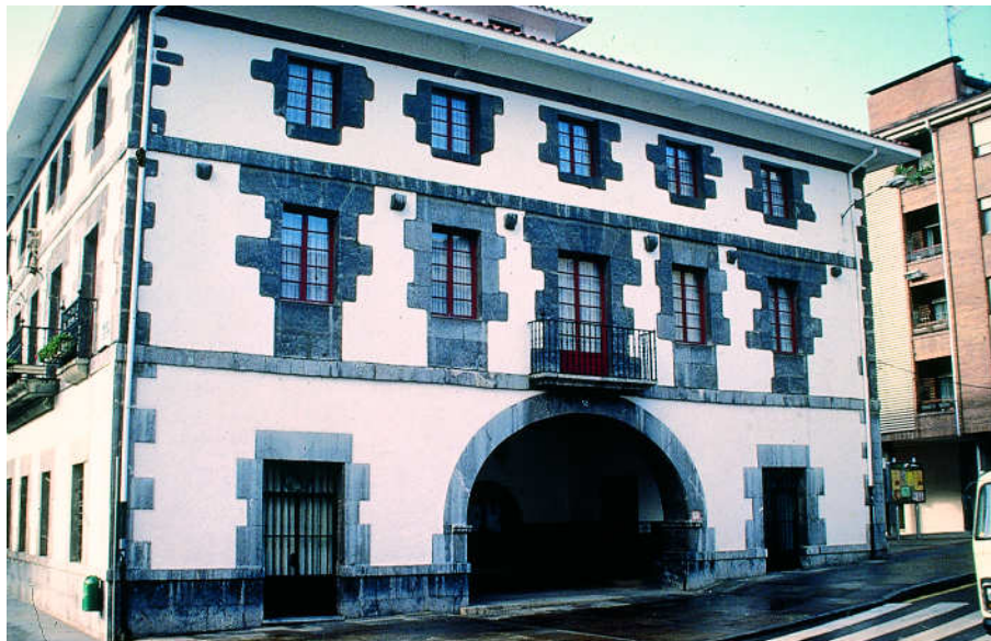
Antiguu Consistorio de la Anteiglesia de Etxebarria, adosado a su templo parroquial.
