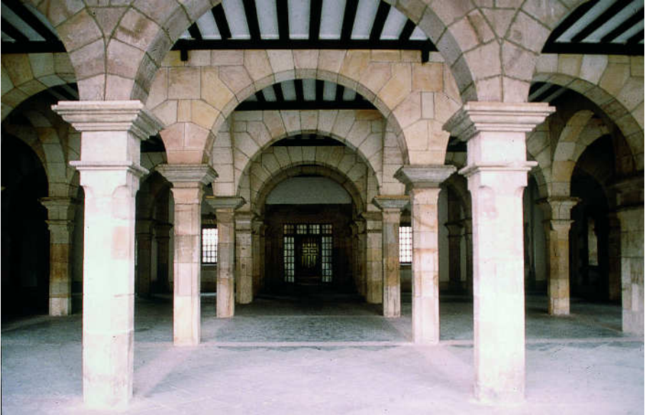
Soportal de la Casa Consistorial de Balmaseda. Es fruto de dos reformas sucesivas entre 1900 y 1919.
