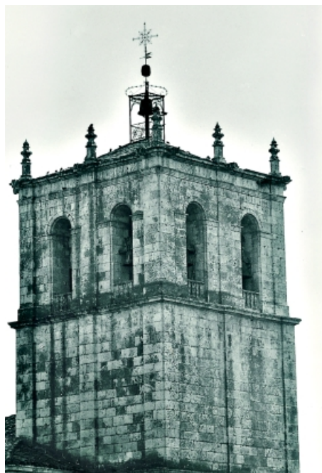
Detalle de la Torre de la Iglesia Parroquial de Sotillo de la Ribera (Burgos).
