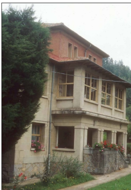
Casa de Sobera. Detalle de la fachada principal.
