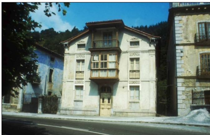
Casa de Juan José Saínz de Rozas. Fachada principal.
