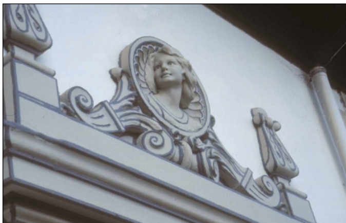
Casa de Martín Gómez de Allende. Detalle de la fachada principal.
