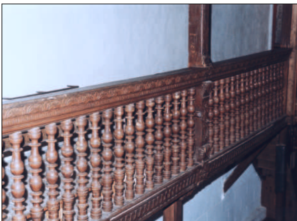
6. Louhossoa: Sainte-Marie, galerie sur consoles.
