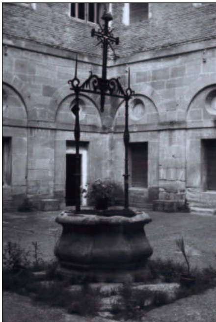
Fig. 8. Pozo del claustro, San Francisco de Viana. Trazo de J.B. de Suso.
