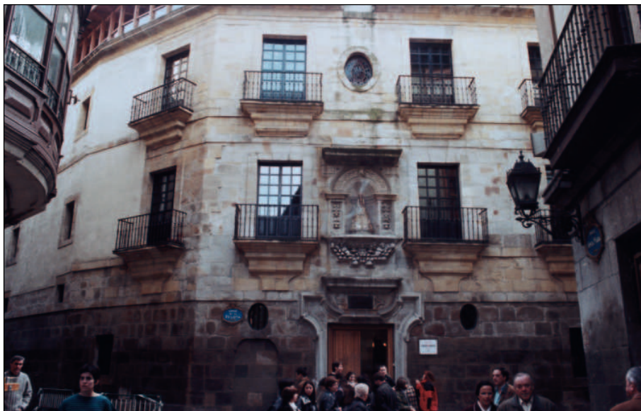
Palacio de "La Bolsa" o "Casa John". Edificado en el segundo cuarto del s. XVIII, es uno de los más espectaculares edificios que se levantaron en la villa durante este periodo.
