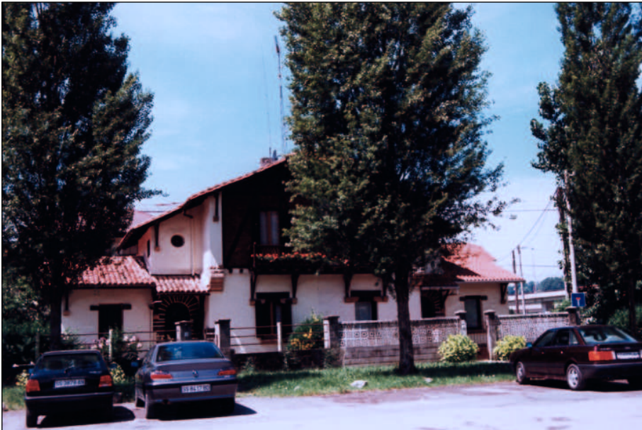
Fig. 8. Fachada de la villa A.
