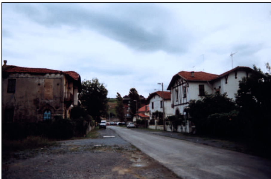
Fig. 15a. Calle Matxinene. A la izquierda villa D y a la derecha la villa C. Línea del límite construido. Imagen sacada desde donde se había proyectado la plaza circular. A nuestra espalda queda el viaducto de la autopista.
