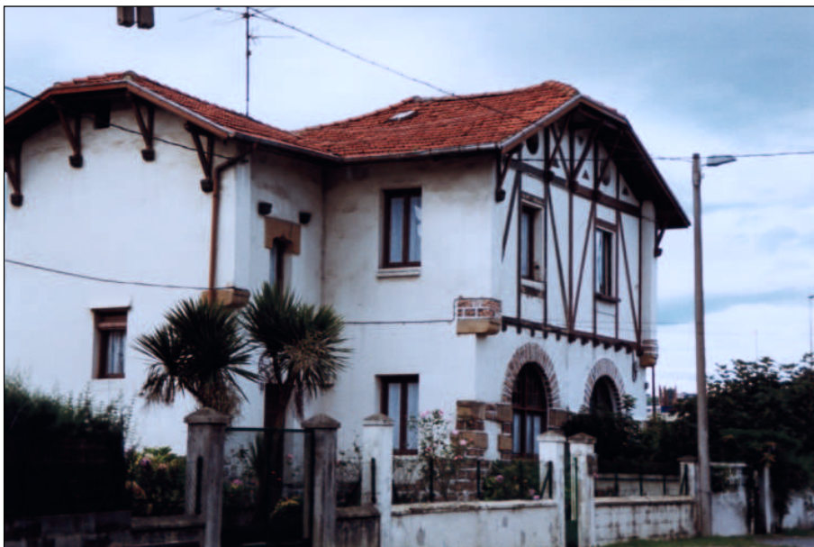
Fig. 10a. Fachada villa C.
