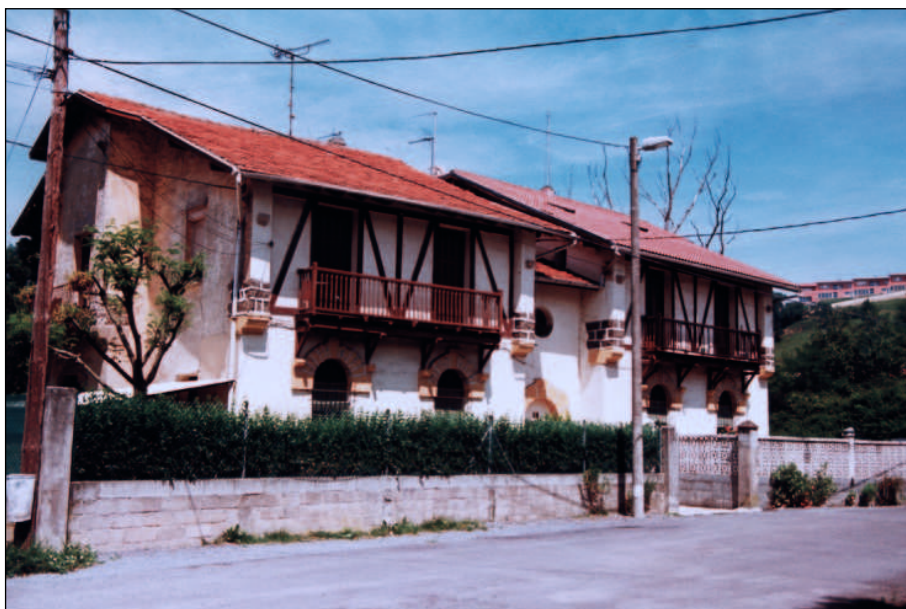
Fig. 12a. Fachada villa E.
