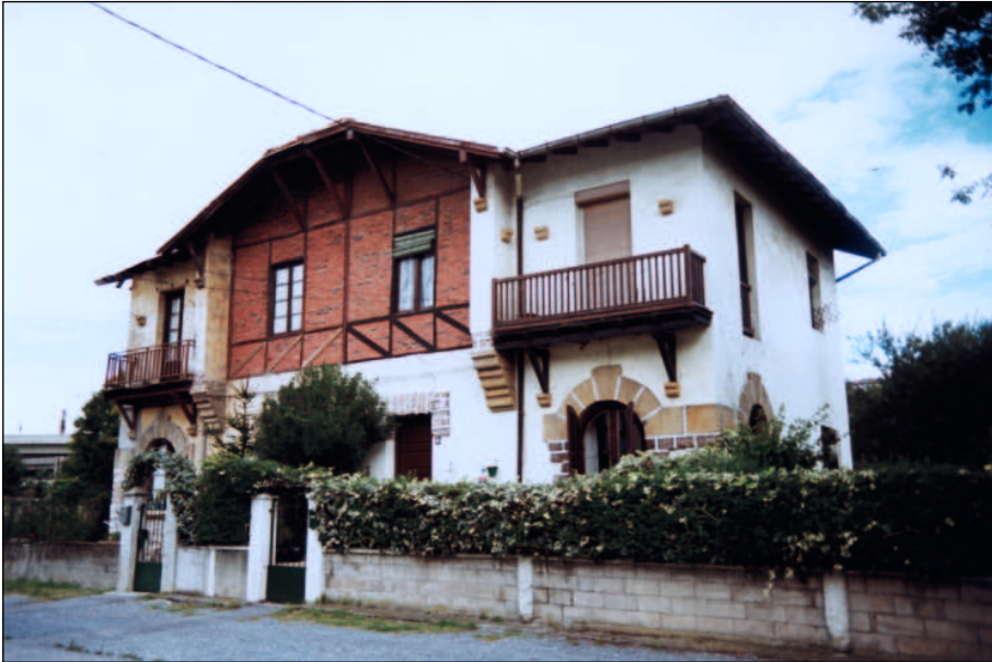
Fig. 11a. Fachada de la villa D.
