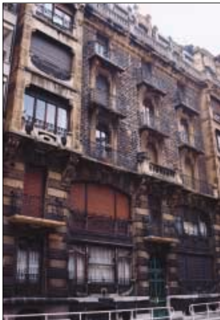
Fig. 5. Fachada vivienda de la calle Zubieta, 1E.
