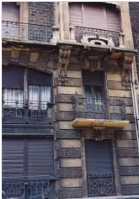
Fig. 7. Fachada de la calle Zubieta, 1E.
