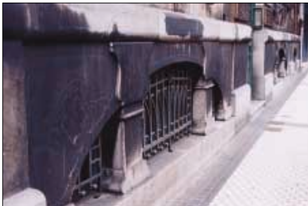
Fig. 6. Zócalo del edificio de Zubieta, 1E.
