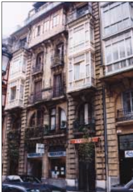
Fig. 3. Fachada vivienda de la calle Moraza, 5.
