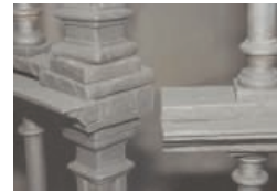
Fot. 48. Heredia. Decoraciones cinceladas en frío. Marcas de montaje.
