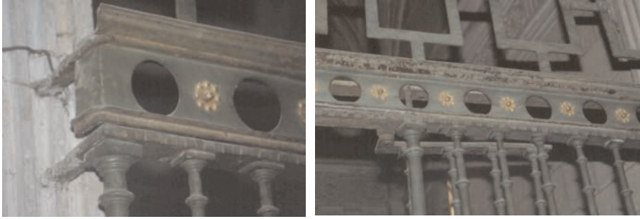
Fots. 52 y 53. Salvatierra. Parroquia de San Juan. Entablamento de la reja y detalle del anclaje al muro.
