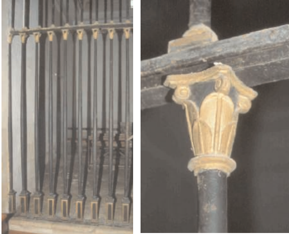
Fots. 56 y 57. Munain. Columnas del cuerpo inferior de la reja.
