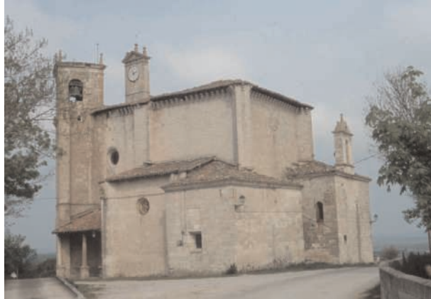
Fot. 40. Vicuña. Vista exterior de la parroquia.
