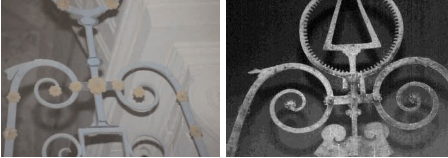
Fots. 45 y 46. Heredia. Detalles decorativos del coronamiento, ensamblajes con remaches y piezas reaprovechadas.
