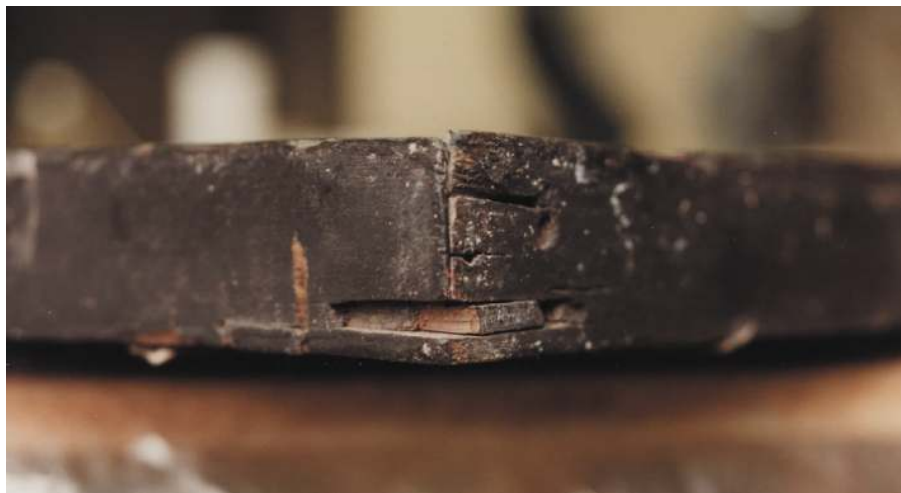
Detalle constructivo. Angulo del marco.
