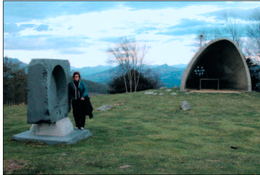
Estado actual de la Estela funeraria de Jorge de Oteiza y la Capilla del arquitecto Luis Vallet. Memorial al Padre Donostia, proyectado y realizado entre 1956 y 1959. Puede observarse que ni en la escultura de 1957 (fueron tapadas), ni en la piedra de Agiña se realizaron las perforaciones indicadas en la memoria.
