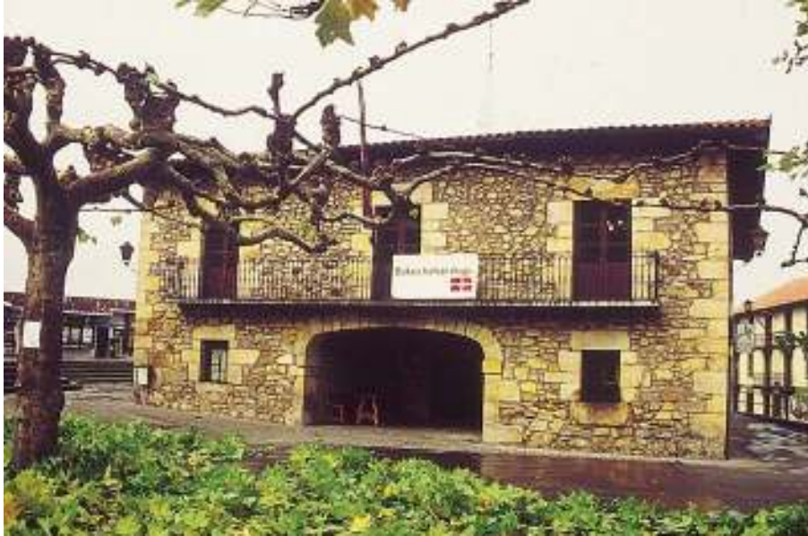
En 1801, el maestro perito Juan Antonio de Zabala, dio las trazas para construir la nueva taberna-consistorio de la anteiglesia de Zamudio.
