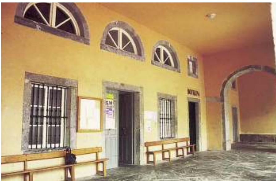
Juan Bautista de Belaunzaran proyectó este edificio en 1822. Detalle del interior del soportal.
