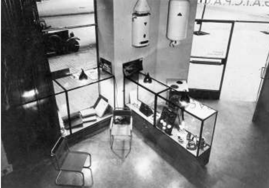
GATCPAC taldearen lokala: Construcció i amoblament de la casa contemporània. 1931. Bartzelona (Iturria: © Arxiu Històric del Col·legi d'Arquitectes de Catalunya (GATCPAC)).
