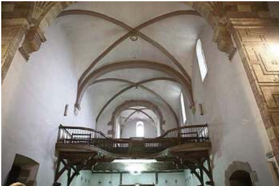
Gartzain. Parroquia de San Martín. Interior de la nave.
