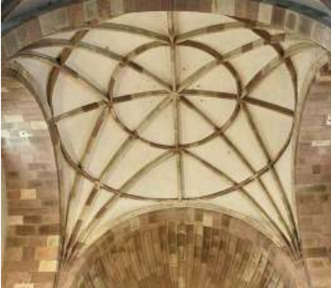
Gartzain. Parroquia de San Martín. Bóveda del crucero.
