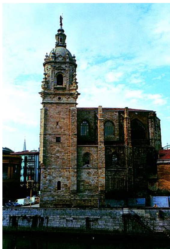
PLANTA Y FOTOGRAFÍA DE LA IGLESIA DE S. ANTÓN Foto: Sergio Martínez
