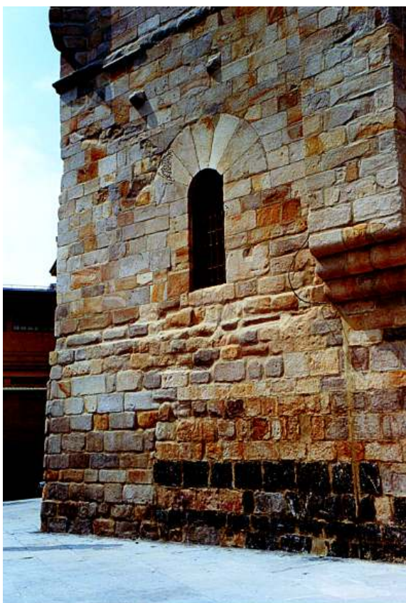
EN LA BASE DE LA IGLESIA DE S. ANTÓN PARECE INTUIRSE LA ESTRUCTURA DEL ANTIGUO ALCÁZAR
