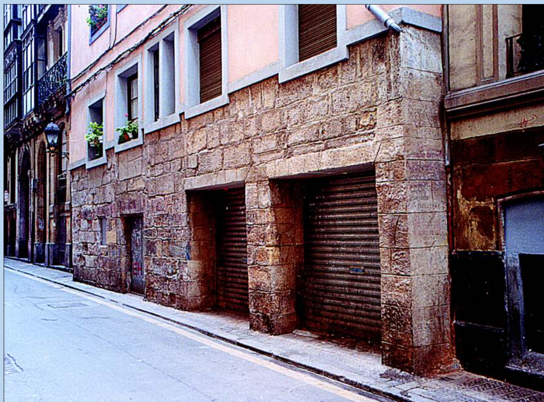
POSIBLE LIENZO DE LA MURALLA EN LA CALLE RONDA
