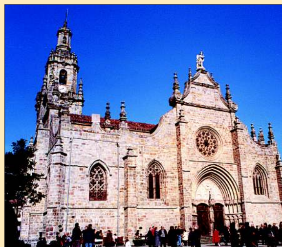
IGLESIA DE S. SEVERINO
