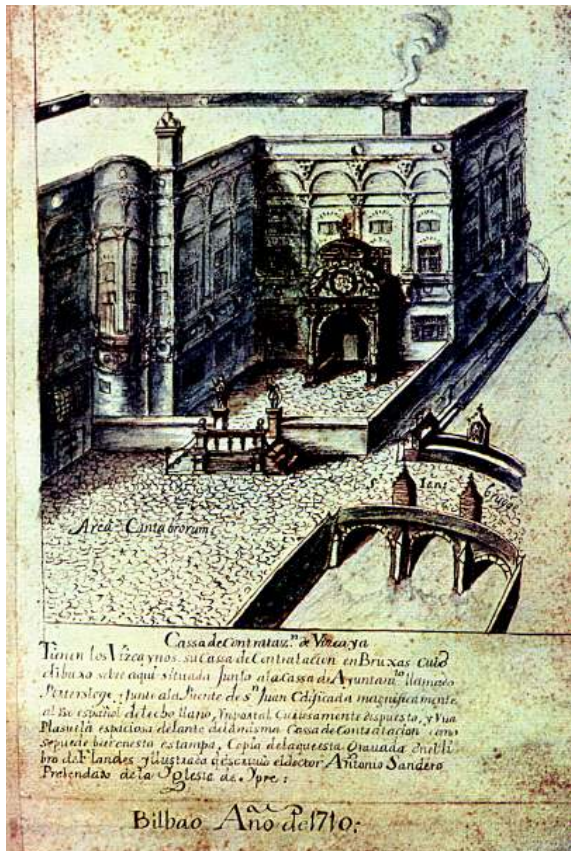
BILBOKO KONTRATAZIO-ETXEA BRUJASEN 100 años de la Junta del Puerto de Bilbao lanetik hartua
