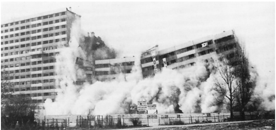
Figura 7. Demolición de la barre Debussy en La Courneuve, en la periferia Norte de París, 1988
