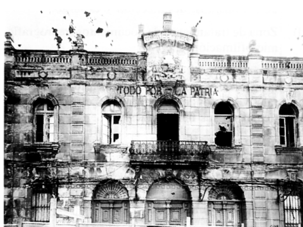
Parte central del edificio en el momento de iniciarse las obras de rehabilitación. (Foto Barroso).
