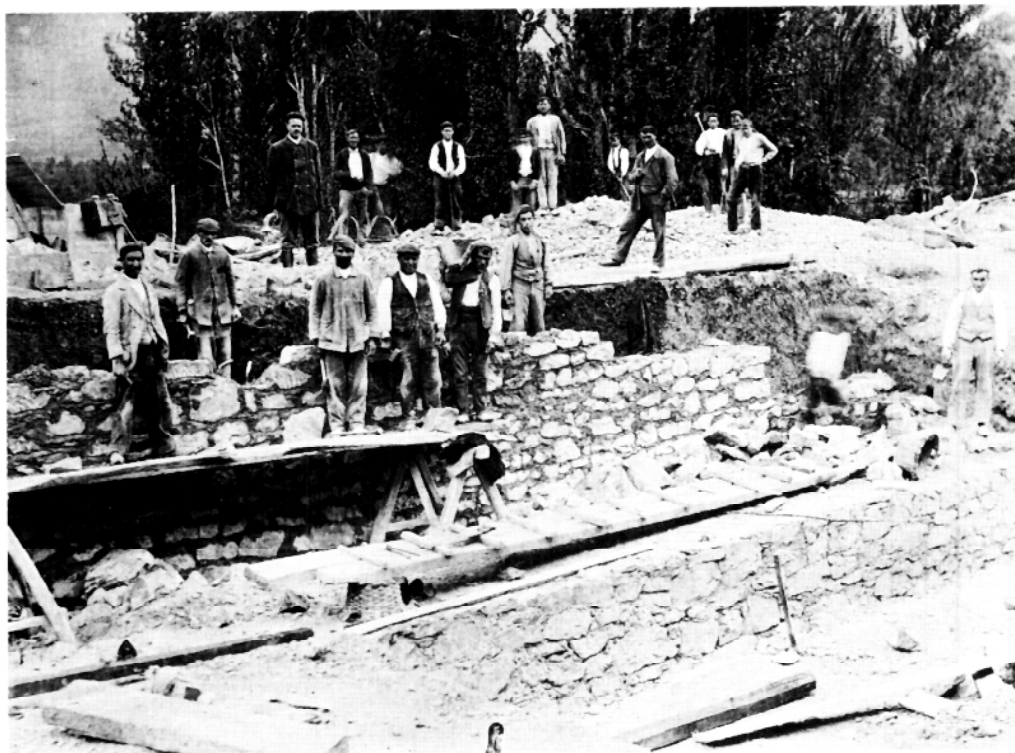
Construcción en la fábrica de cementos Portland «El cangrejo» en Olazagutia
