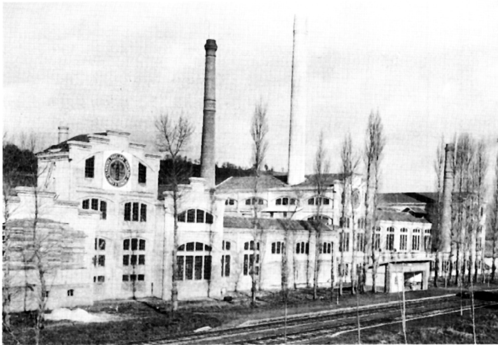
Fábrica original de cementos Portland en Olazagutia
