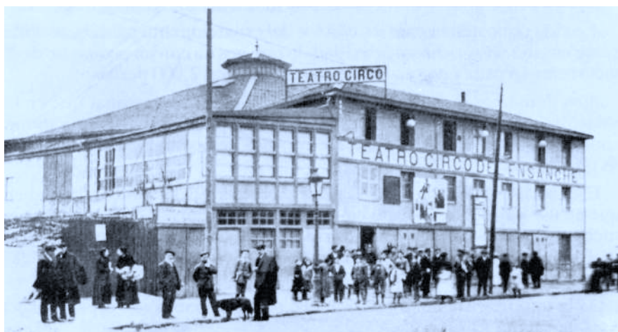
Fachada principal del Teatro Circo de Bilbao en 1912
