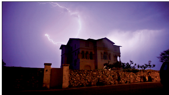
Figura 18. La casa Emak Bakia : un exorcismo frente a la destrucción del tiempo.
