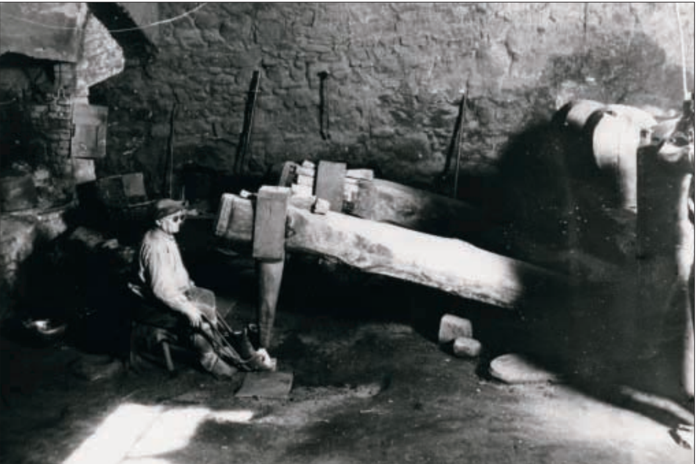
Un «olagizon» trabaja en el «gabioñe»
