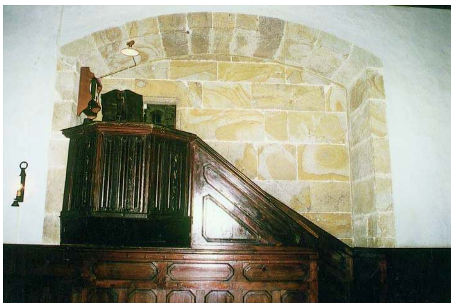
Púlpito del refectorio. Siglo XVI.
