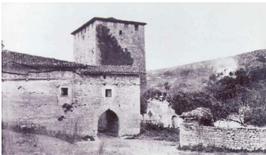
Vista de la puerta de acceso por el norte y Casa-torre de los Velasco.
