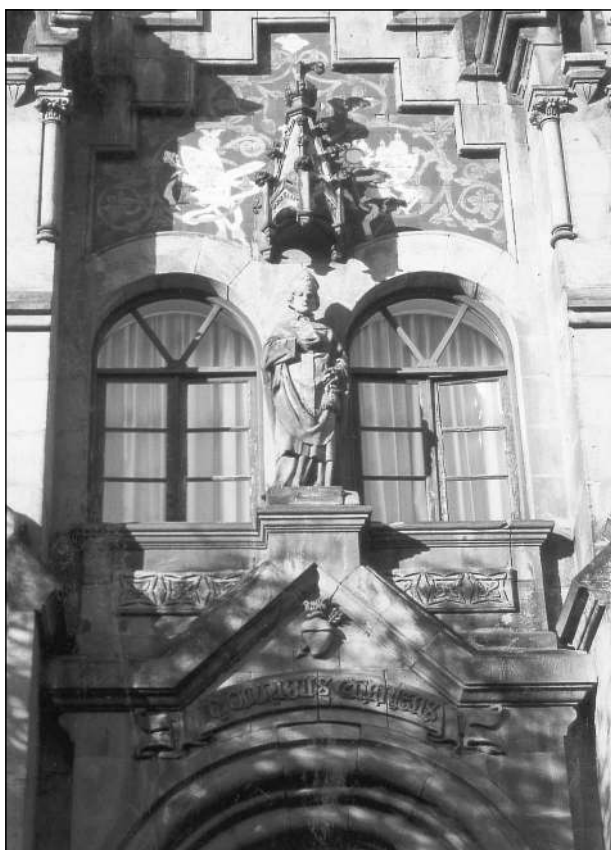
Fachada del antiguo monasterio de los Padres Agustinos, hoy Real de Asúa, realizada en 1902. Portugalete.
