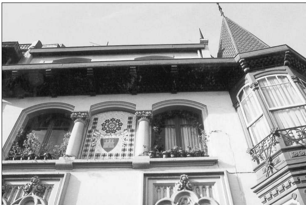
Detalle de la fachada del edificio Bustamente de Portugalete, de claro estilo modernista imitando antiguos palacetes.
