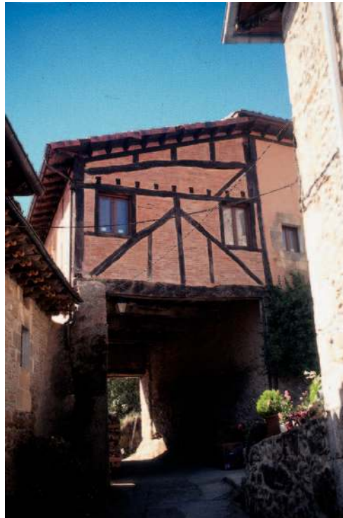
Casa con vigas de madera y ladrillo. Obécure
