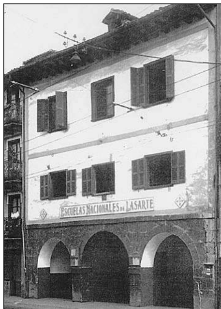
Edificio de las antiguas Escuelas Nacionales, Ayuntamiento actual de Lasarte-Oria.
