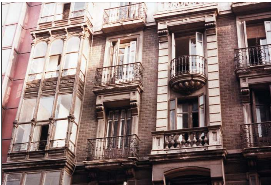
Fachada de su casa de Bilbao.
