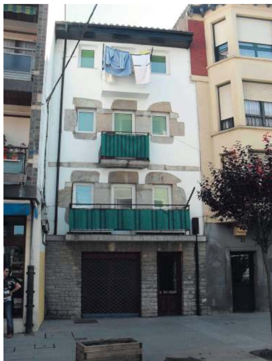
Fig. 1. Casa en Erribera nº 10.
