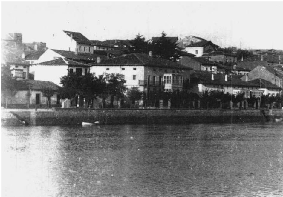
Fig. 12. Vista de los Paseos del muelle en las primeras décadas del siglo XX. Fuente: Colección Museo Plentzia de Butron Museoa.
