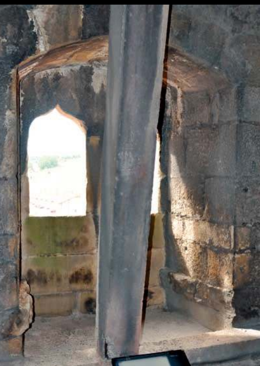
53. Cañón de la ventana geminada conopial del primer piso de la torre.
