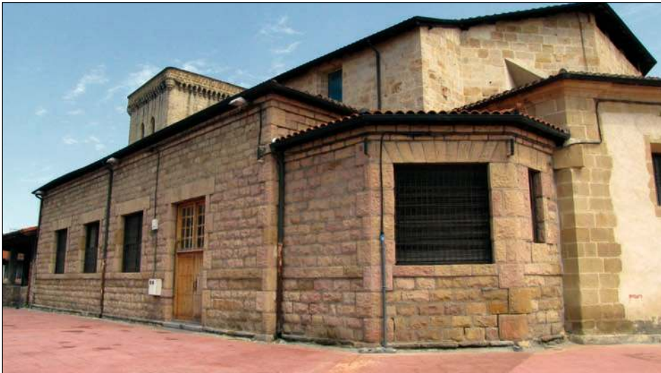
79. Edificio de catequesis.
