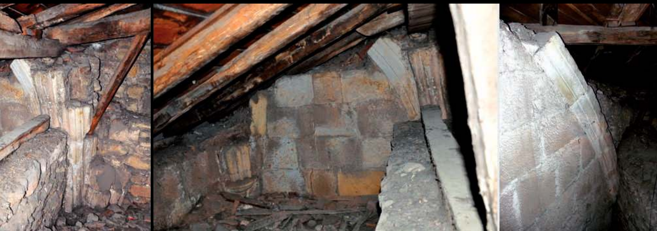
60. Arranques de nervios en la sobrebóveda.
