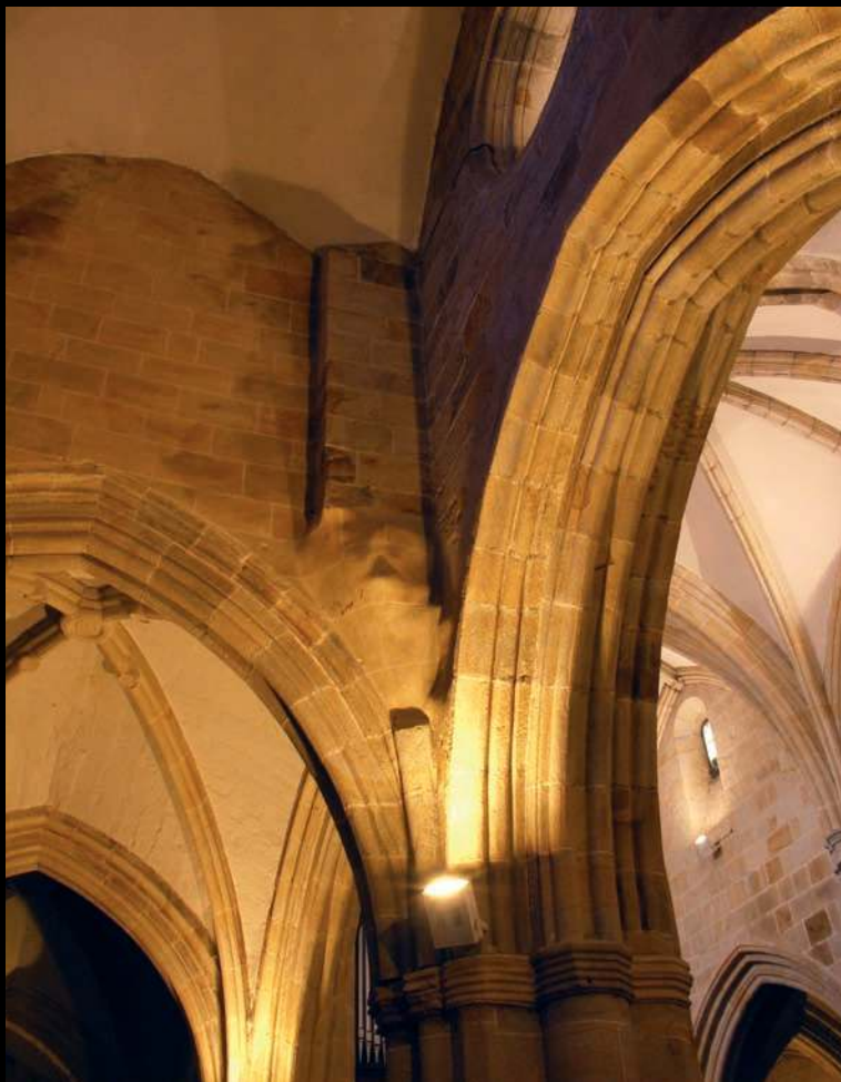
18. Contrafuerte (sobre la columna nº 11).
