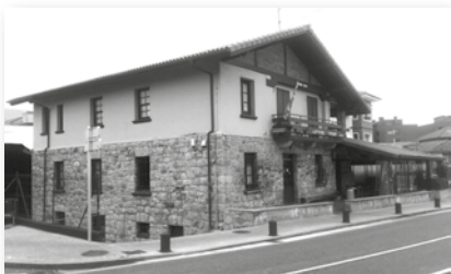
Batzoki zaharrak ostatu izaten jarraitzen du, Txiberri Taberna historikoa bertan dagoelarik / El edificio en la actualidad sigue conservando su uso hostelero, albergando la histórica Taberna Txiberri. (Koldo Somokueto)
