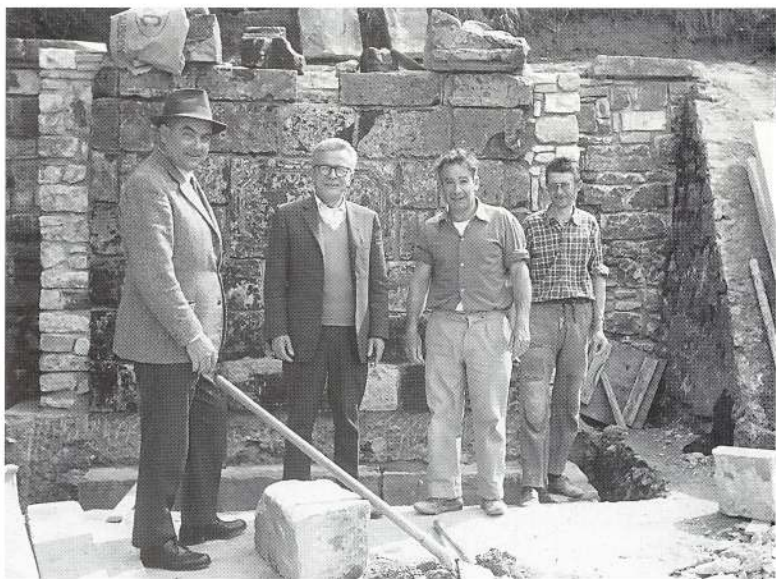
Baiona, 1967. Travaux de restauration de la Tour de Sault. Eugène Goyheneche avec l'architecte de la ville et deux des ouvriers.
