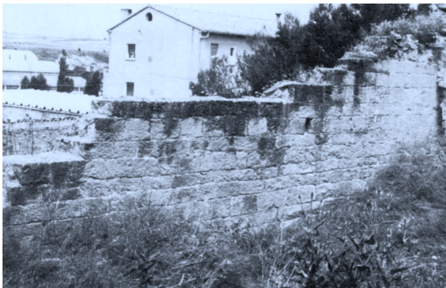
19. PORTAL DE ARTAJONA (Salida calle Misericordia): Restos de la muralla medieval.
