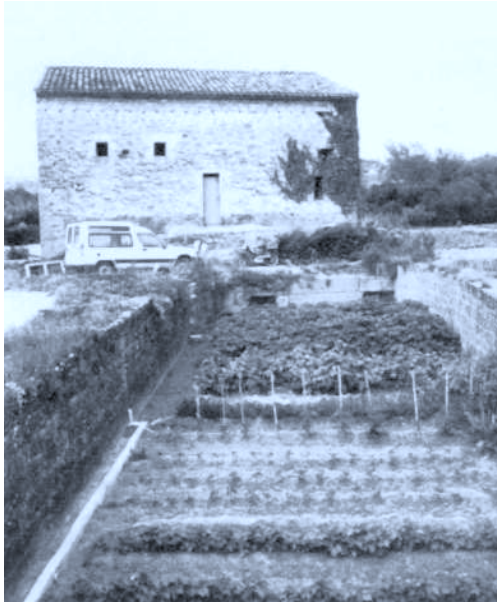
18. CONGOSTO: Molino . Terminación de la cequia molinar, convertida en huerta; al fondo del muro, los dos bocales de entrada del agua a las turbinas.
