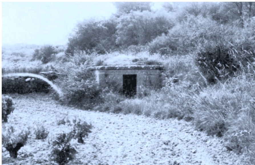
13. VALGORRA: Fuente del Rey . Exterior del nacedero (1845).
