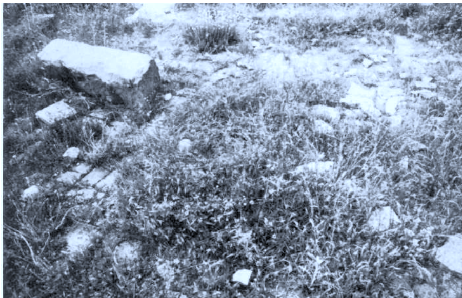
21. ALTO DE LAS CRUCES: Basílica de San Cristóbal . Pavimento enladrillado de la nave, en descomposición.
