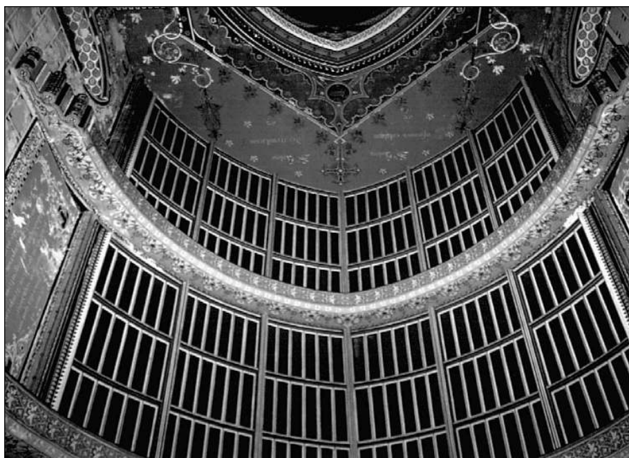
19. Castillo d'Abbadie. Cubierta de la capilla.
