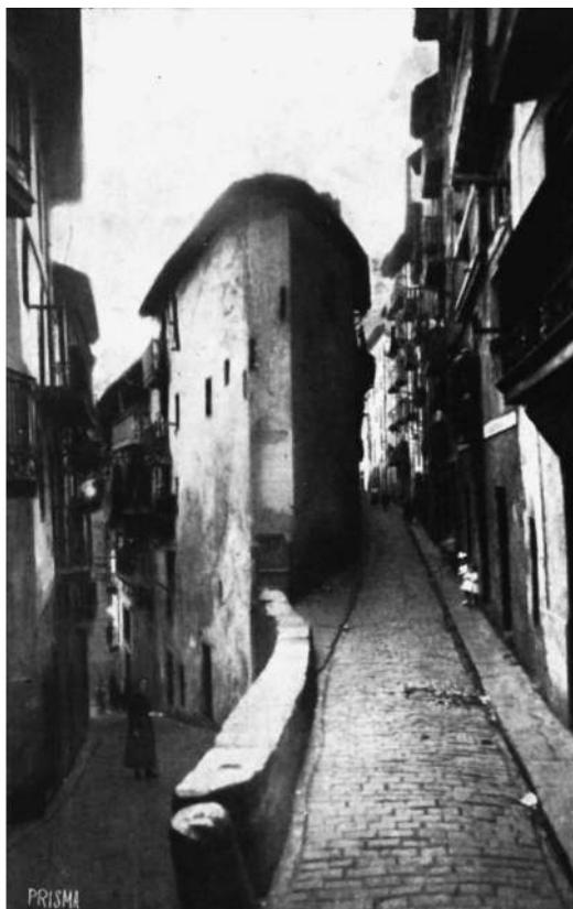
Calles angostas y viviendas de pescadores en Ondárroa
