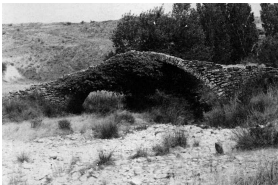
Foto 8. Puente romano de San Vicente.
